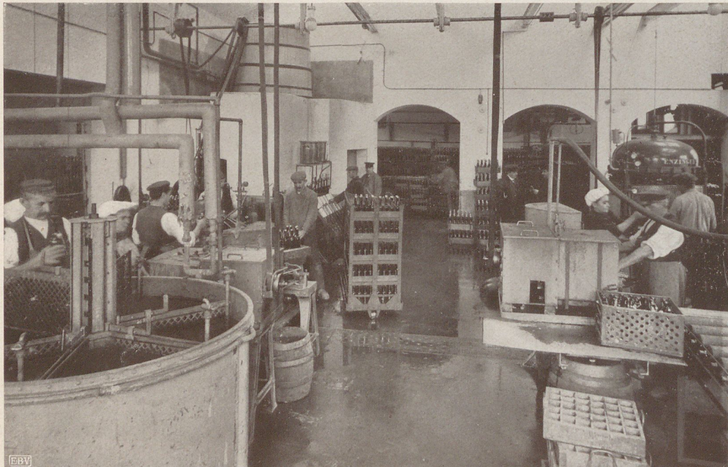
Flaschen-Reinigungs- und -Abfüllanlage
