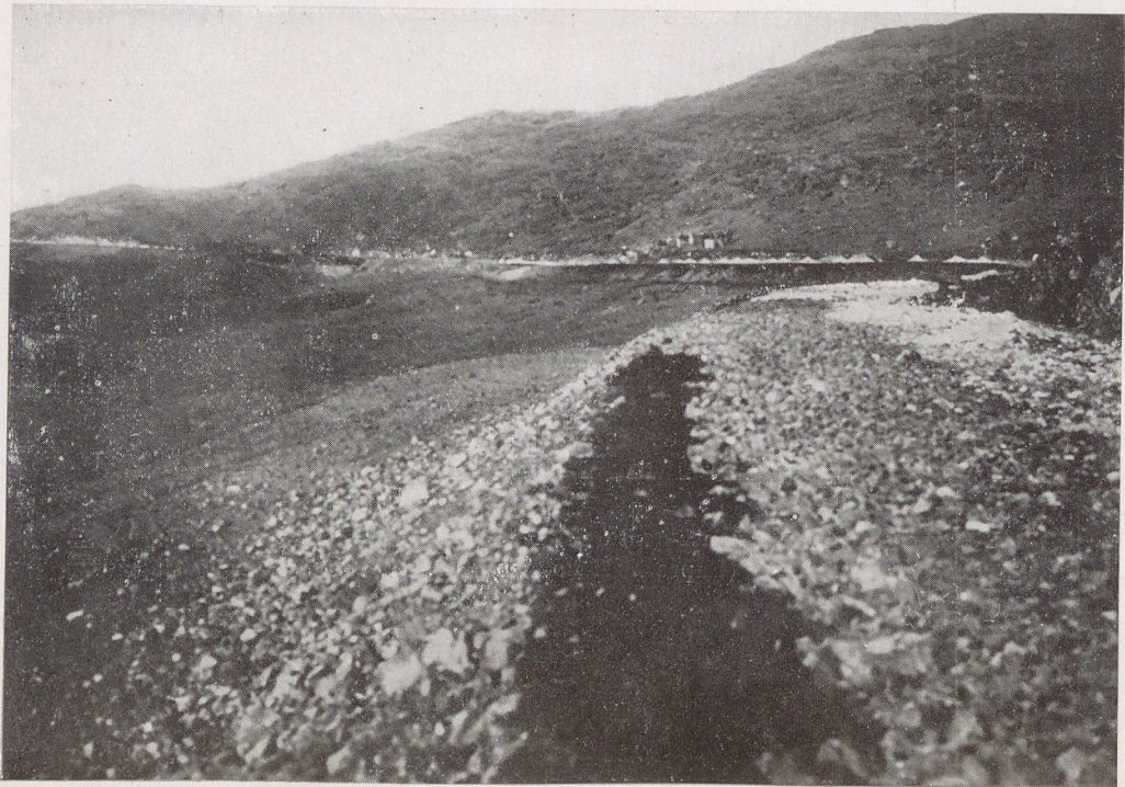
Strada Scutari-Puca-Ponte di Veziri - 1° tratto in costruzione (Impresa Nush Topalli, Scutari)
