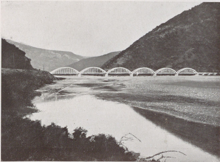
Il nuovo ponte «Zogu» costruito dall'impresa Mazorana e C. di Trieste.
