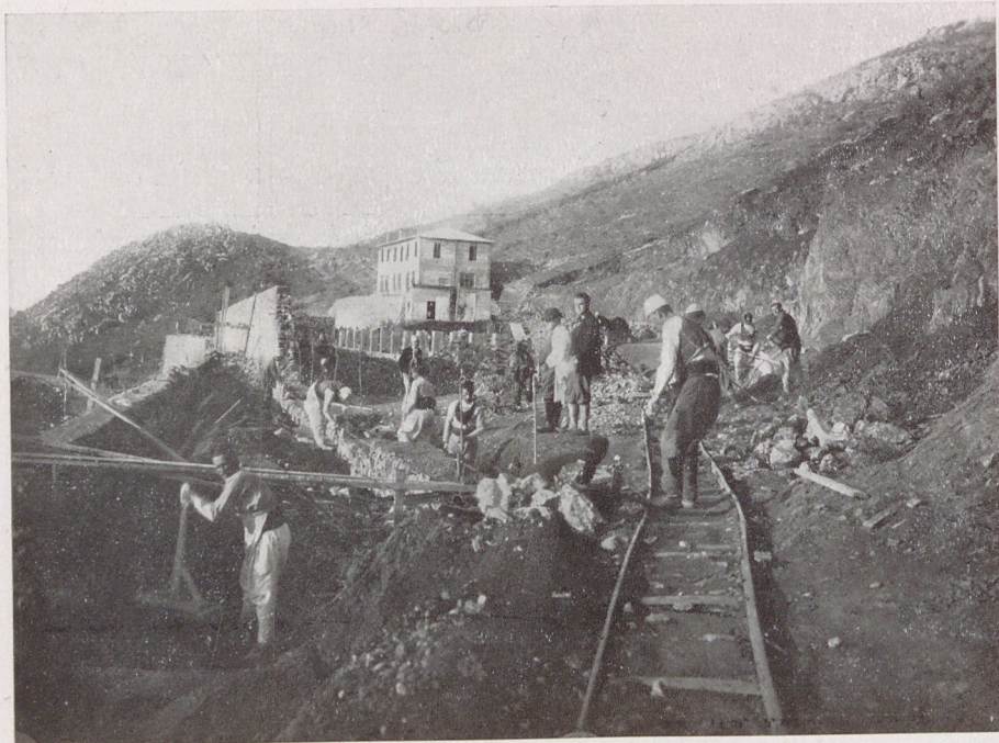
Fabbrica di cemento a Scutari - Installazione degli impianti.
