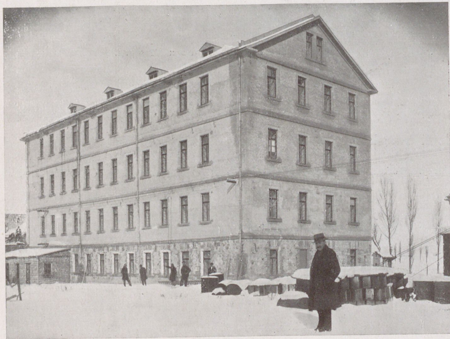
Mulino elettrico a Coriza.
