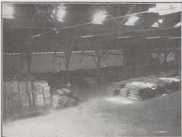
HALL-ENTREPÔT DES ÉTABLISSEMENTS RANNOU
