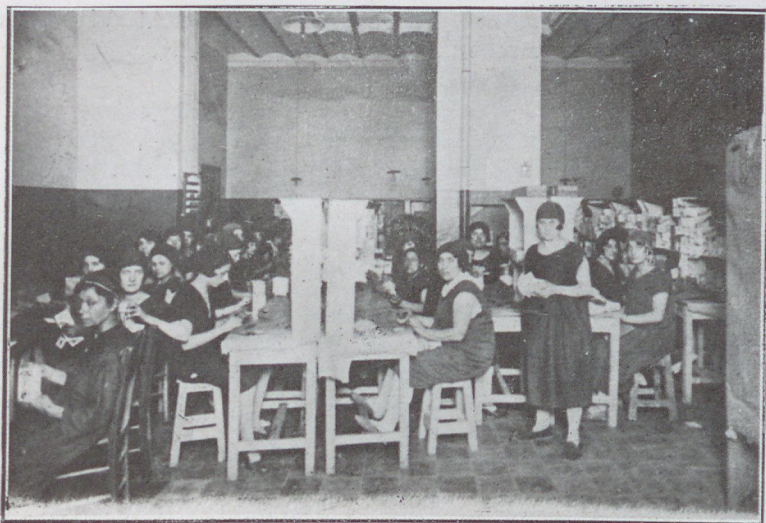
LA SALLE DE REMPLISSAGE
