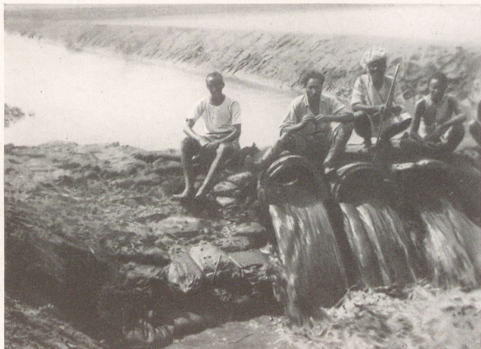
Bewässerungsanlage bei Tefzenei
