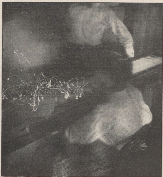
Fig. 3. Photographische Aufnahme der Arbeitsverrichtung einer Textilarbeiterin. Die Willkürlichkeit und Ungeregeltheit ihrer Bewegungen ist deutlich erkennbar.
